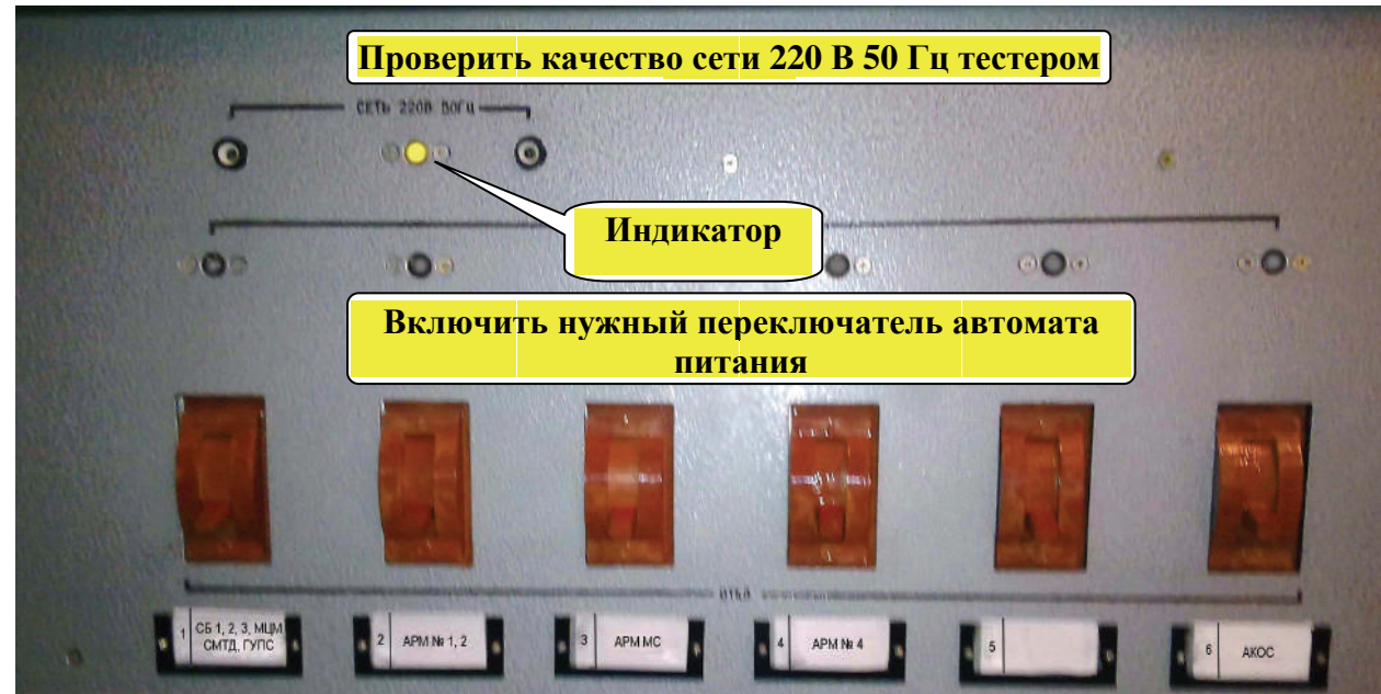
Рис. 1.2. Распределительный щит-6
